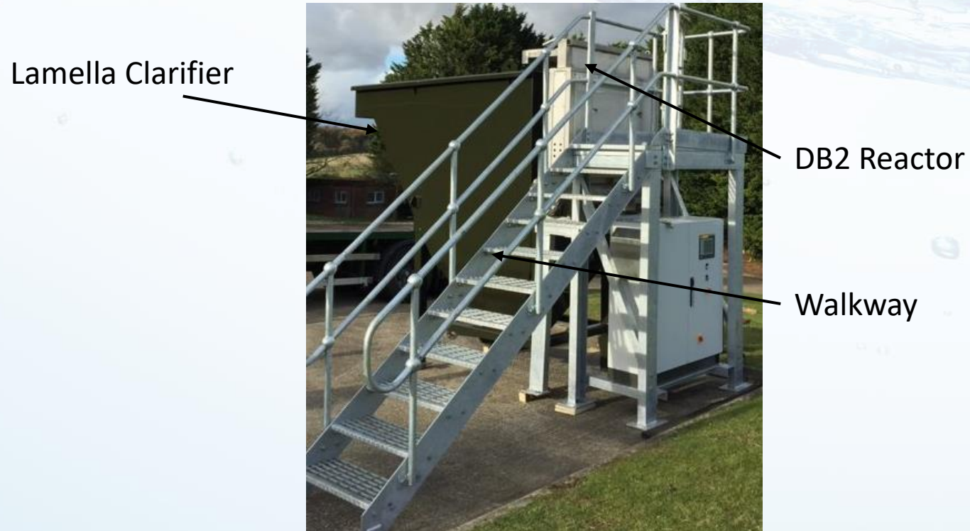
Sono EC (DB2) with Lamella Clarifier
